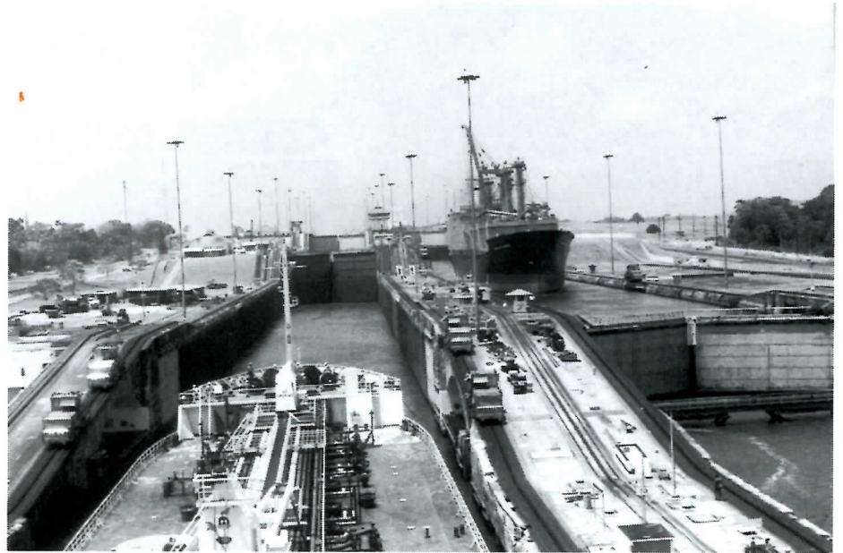
Een hoogteverschil van 30 meter moet worden overbrugd
